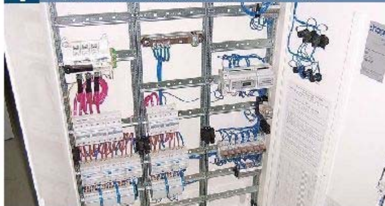
Рис. 3. Внутренний вид шкафов управления системой электрообогрева ТЕПЛОСКАТ на основе корпусов серий FW HAGER
